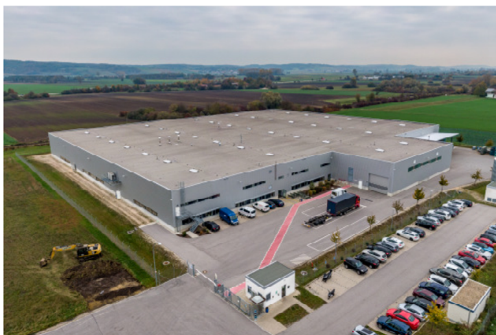
BMW Werk 2.72 im Industrie- und Gewerbegebiet Nord (Altbestand)
